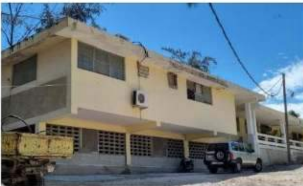
Bâtiment de l'INAREM et du BME de 1980 à date (Delmas 33)
