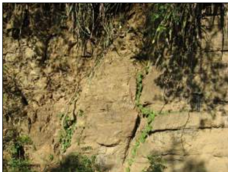
Illustration 23 : Fracture N115°E - 78°S décalant des bancs de turbidites du Crétacé.
