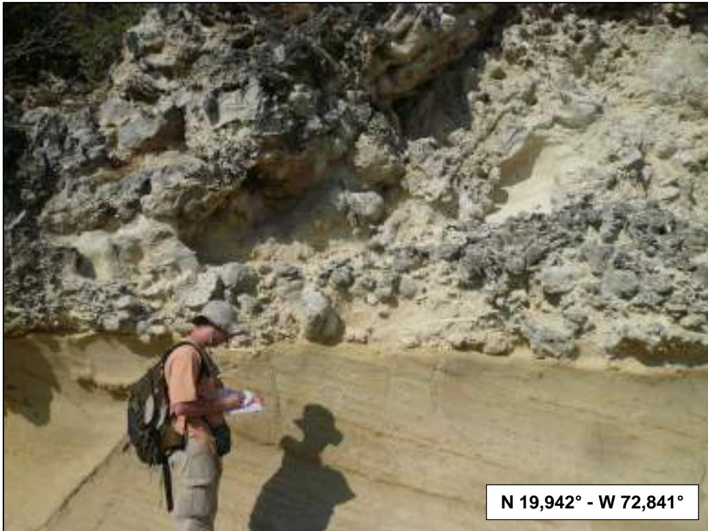
Illustration 17 : Contact discordant entre les calcaires récifaux et conglomératiques de la Fm La Isabela, et les marnes beige jaunâtre de la Fm Villa Trina.
