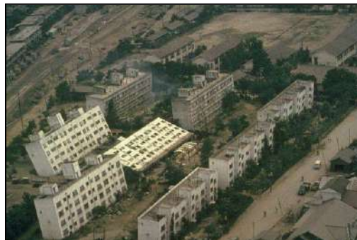
Effet de la liquéfaction à Nigata au Japon suite à un séisme de magnitude 7.5, le 16 juin 1964
